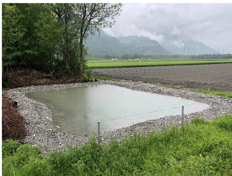
Eines der sieben ephemeren Stillgewässer, welche als Ersatzmassnahme gebaut wurden.
