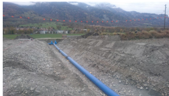
Im Bereich der Zuleitung von der Grundwasserpumpstation ist der Boden sehr flachgründig. Das Rohr wird im kiesigen Untergrund verlegt.
